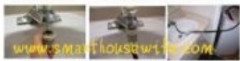
2. 将快速转换接头 3. 使用时, 将洗衣机进 连到出水口 水管套在快速接头上, 这个快速转换接头同样适合厨房水池出水口
